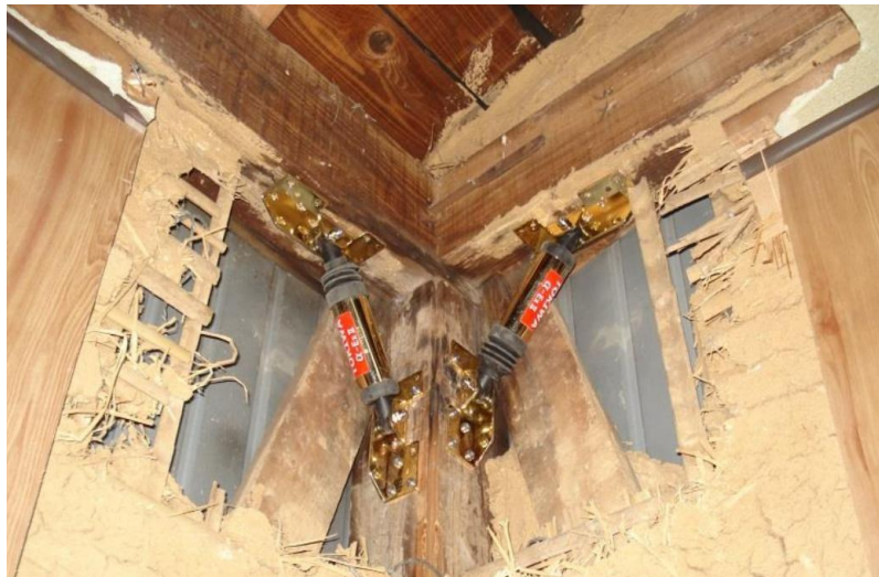
土壁を削ってダンパーを設置した例
