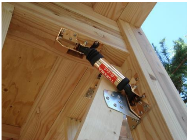
筋かいとの併設可 (筋かい金物内使い)
